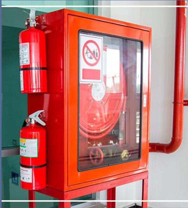
A Engenharia de Incêndio aplicada, prevê o funcionamento dos Sistemas de Hidrantes através de acionamento automático quando houver abertura de qualquer ponto de hidrante devido à queda de pressão previamente reguladas, através de pressostatos comandados pelo painel de controle das bombas entrando em funcionamento automaticamente.
